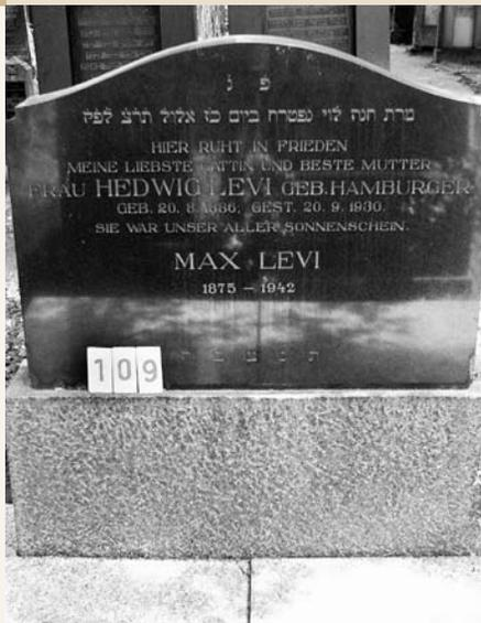
Hier handelt es sich um ein Doppelgrab. Der Grabstein steht auf einem Sockel. Das Grab ist mit zwei Bodenplatten abgedeckt. Stein und Sockel sind aus Granit, die Bodenplatten aus Marmor auf Kunststein gesetzt. Sie sind in gutem Zustand.
